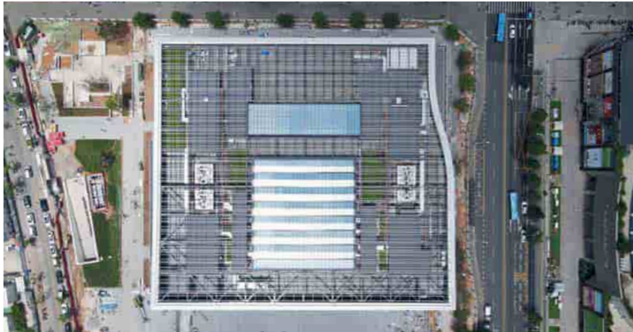
Ansicht des Bibliotheksdachs View of the library roof
