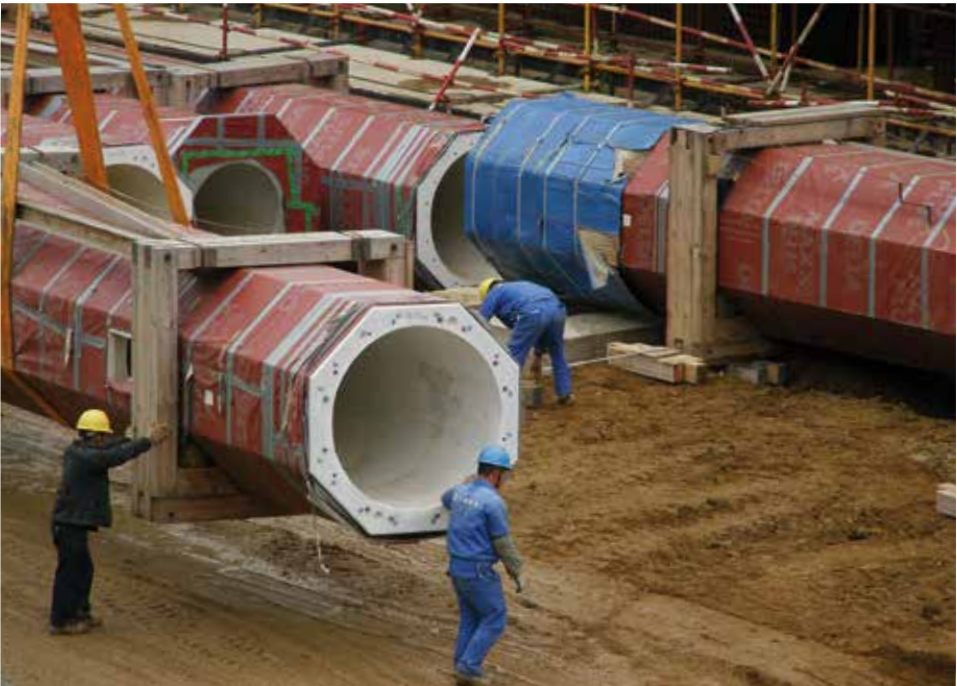
Ankunft und Installation der Schleuderbetonstützen Arrival and erection of the spun-concrete columns
