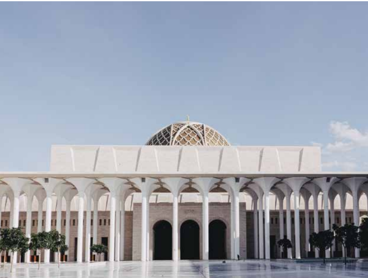
Blick vom Vorhof (Cour) auf den Gebetssaal (mit Kuppel) View from the cour towards the prayer hall (with dome)
