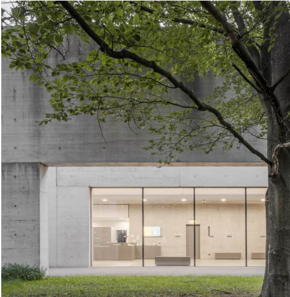
入口处 Entrance area
