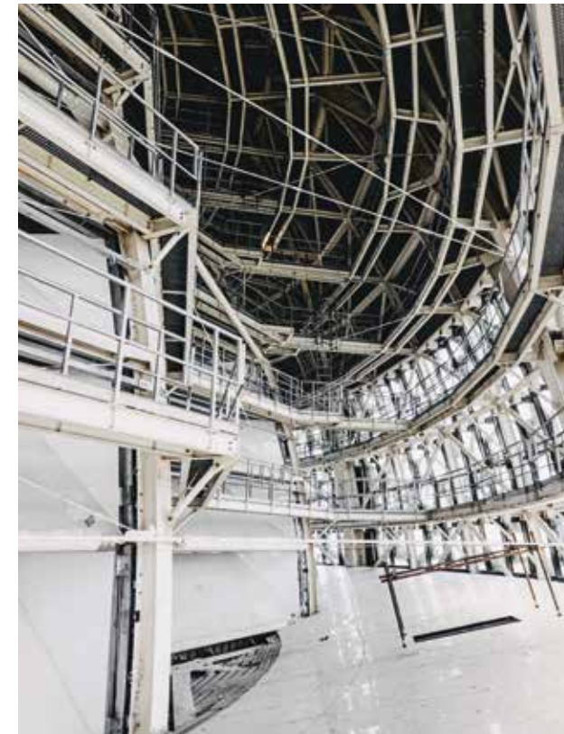
Zwischenraum der beiden Kuppelschalen Space between the two dome shells
