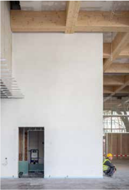
木结构混合结构在壳体结构中的应用 Hybrid timber construction at the building shell stage
