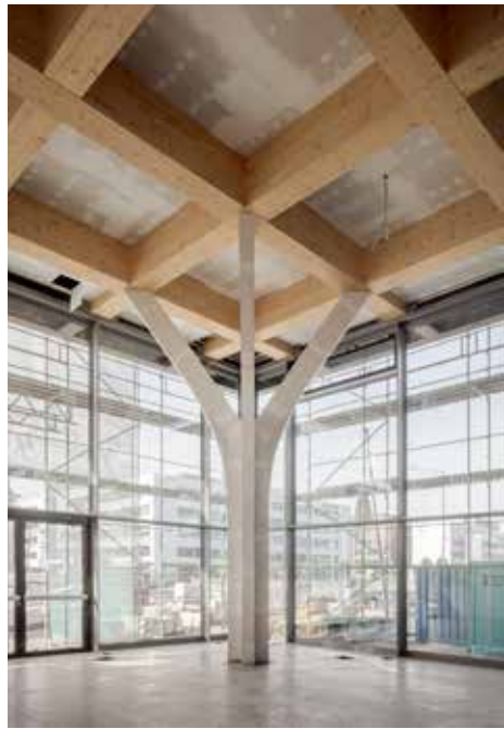
接待楼入口大厅, 主体结构 Reception building entrance lobby, building shell
