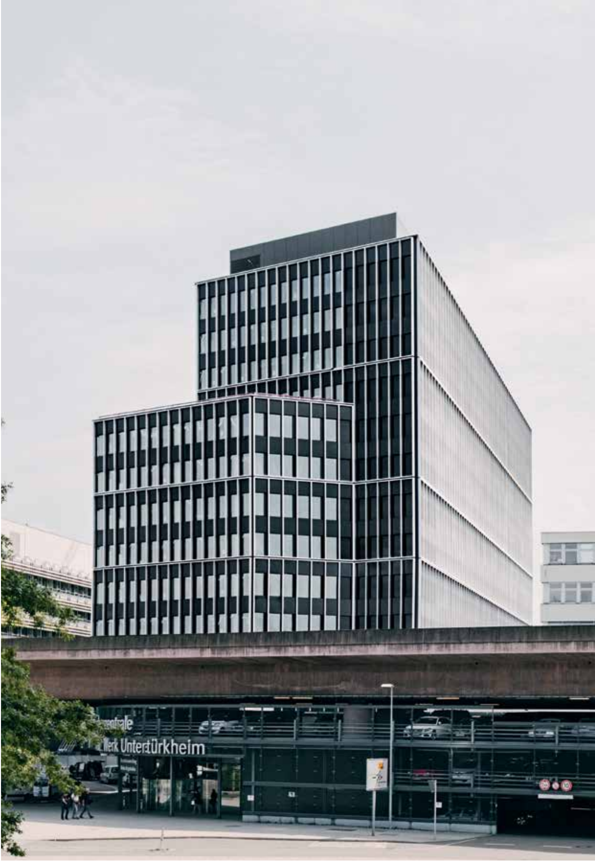
按照现行技术建筑标准和企业形象进行视觉翻新。
