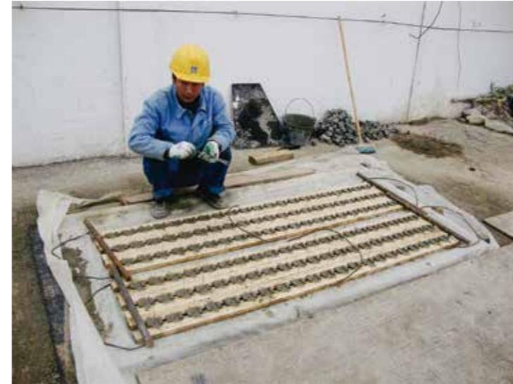
Herstellung von Abstandhaltern aus Gießbeton mit Ösendraht auf der Baustelle
