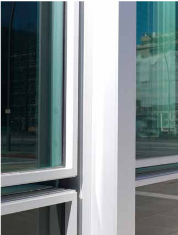
Ansicht der Kastenfenster mit Prallscheibe und Leichtmetallrahmen View of the coffer windows complete with impact pane and light metal frame
