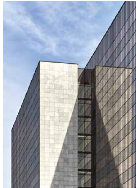
Arne-Jacobsen-Bau vor der Sanierung Arne Jacobsen Building prior to modernization
