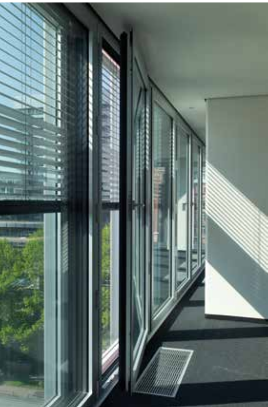
Detailaufnahme der neuen Fensterflügel Detailed view of the new casement windows
