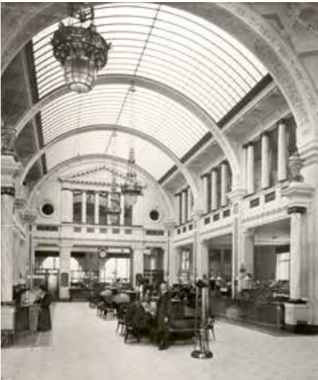
Die große gläserne Tonne der zentralen Kassenhalle versteckte man beim Umbau hinter einer flachen Gipsdecke. Die Substanz blieb allerdings unangetastet und konnte freigelegt und wieder instand gesetzt werden.
