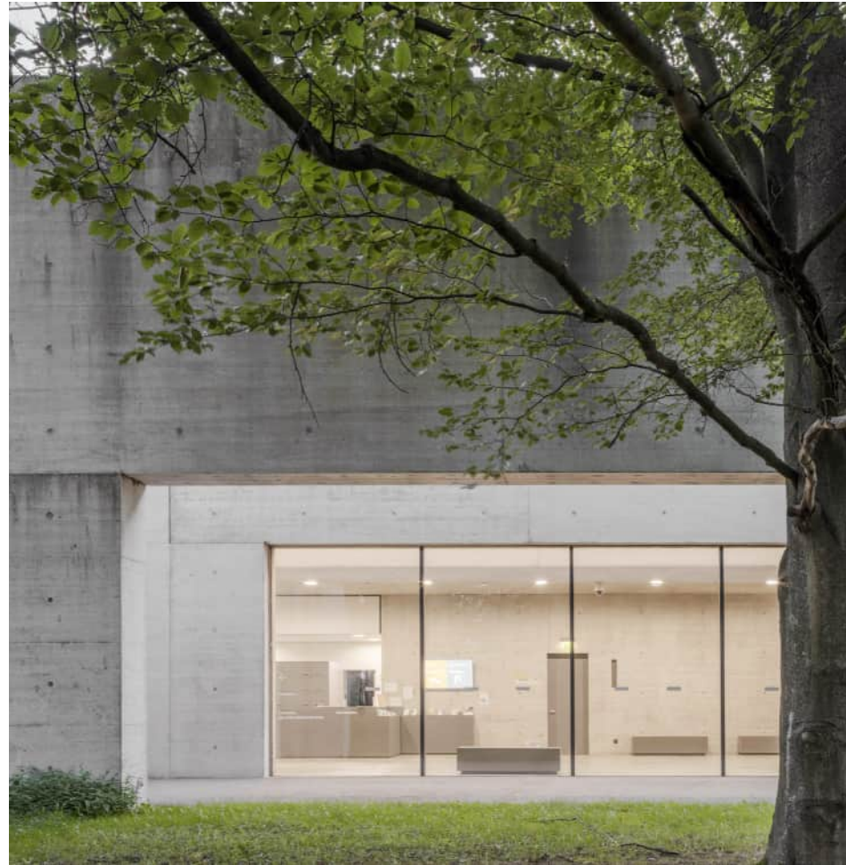
入口处 Entrance area
