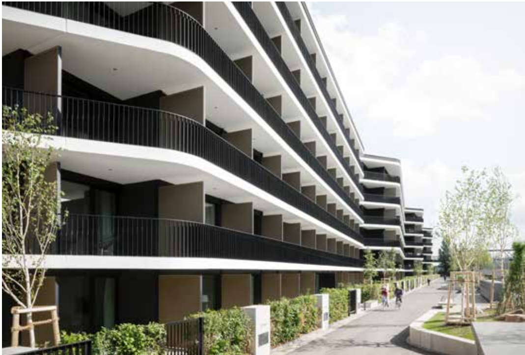
Westansicht vom Gleispark West view from Gleispark
