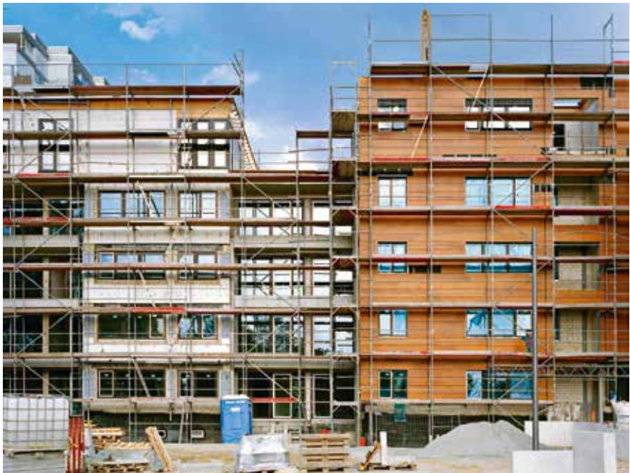
Rückbau der Hochhausanlage Reducing the high-rise complex
