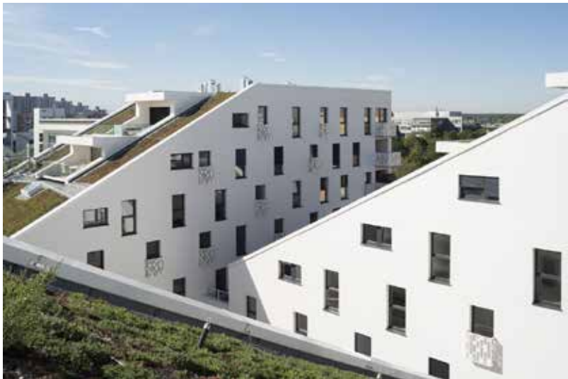
Blick über die Schrägdächer View over the slanting roofs
