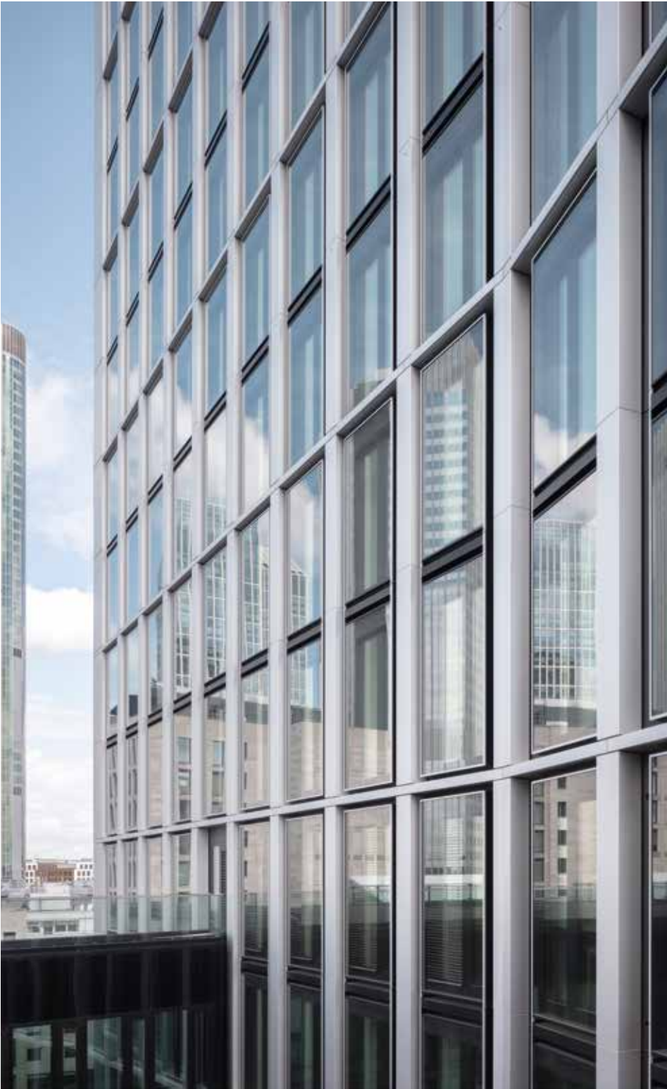
Eine weitere Besonderheit ist der hohe Grad der Vorfertigung der Elementfassade, die optisch immer zwei Geschosse zusammenfasst. Another feature: the notable scale of prefabrication in the façade elements, each of which visually bonds two stories.
