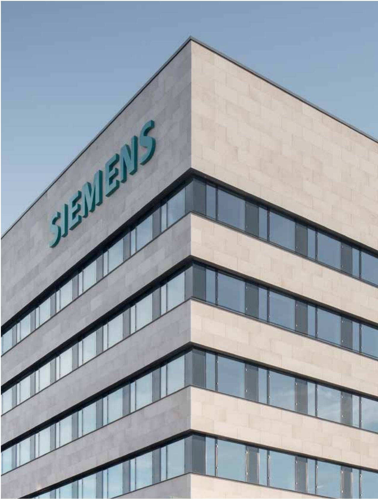
Natursteinfassade des Empfangsgebäudes The reception building's natural stone façade
