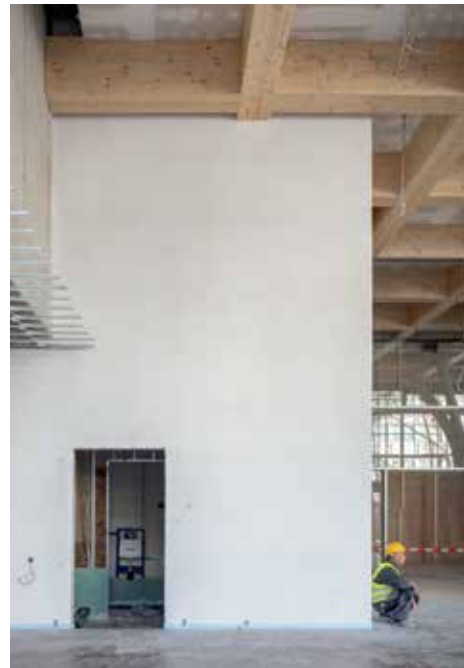
Holzhybridkonstruktion im Rohbau Hybrid timber construction at the building shell stage
