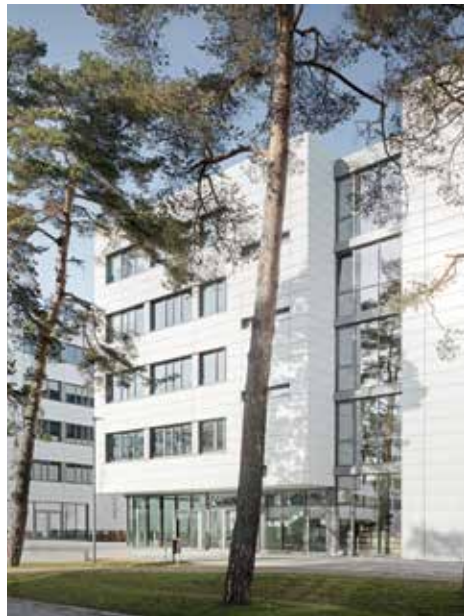
Modul 1, Fassade Module 1, façade
