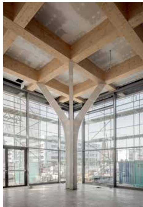
Eingangshalle Empfangsgebäude, Rohbau Reception building entrance lobby, building shell
