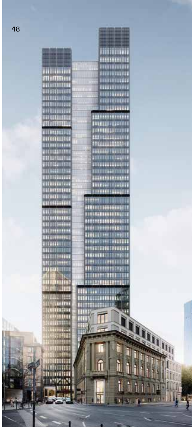
Doppelturm Double tower
