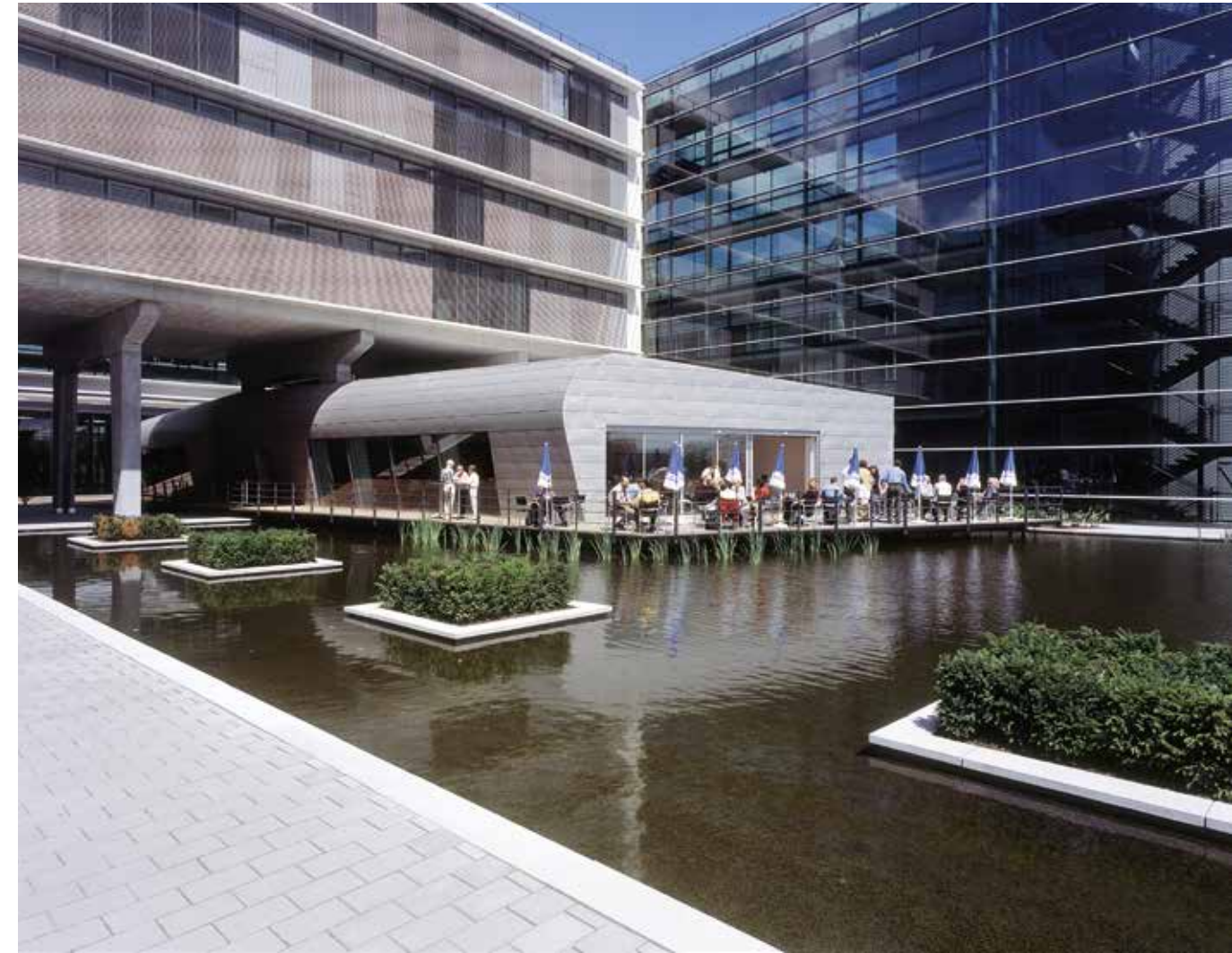
Cafeteria Deutsche Flugsicherung, Langen Cafeteria Deutsche Flugsicherung, Langen
