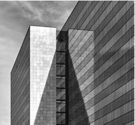
Fassade Bestand Façade existing structure
