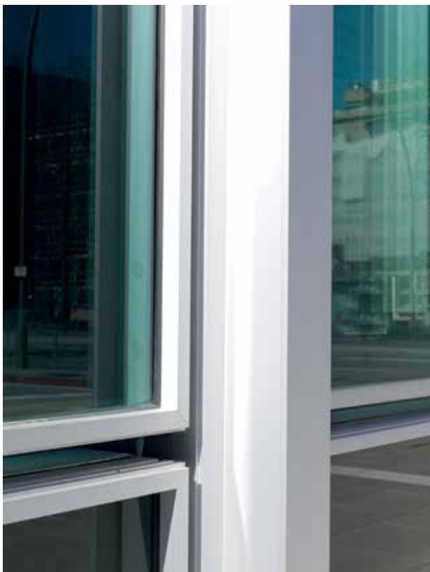
带防撞玻璃和轻金属窗框的箱式窗外观
