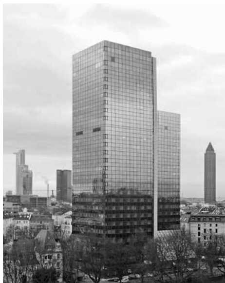
改造前的既有建筑 Old build prior to conversion
