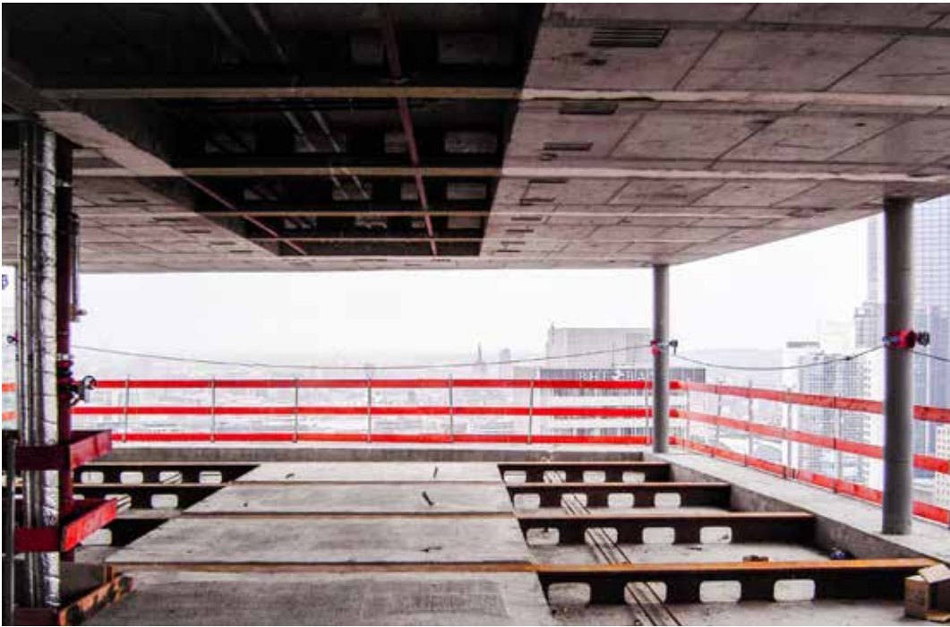
Blick auf die gefaltete Decke (Rohbau/Ausbau) View of the folded ceiling (shell/fit-out)
