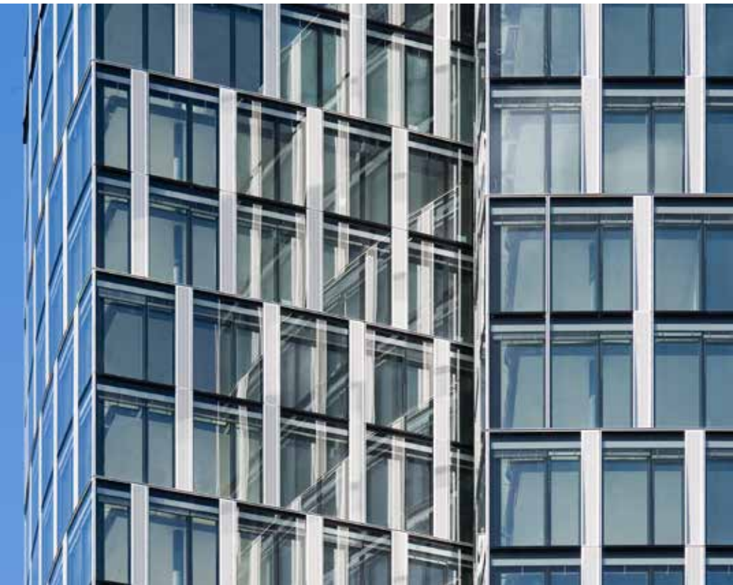
Doppelfassade mit Lüftungsboxen aus Aluminium Dual façade with aluminum ventilation boxes
