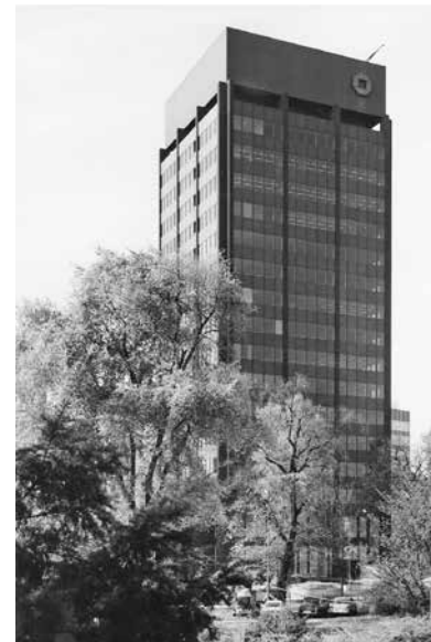
1972年，这座75米高的办公大楼的顶部有一个清晰可见的技术楼层。
