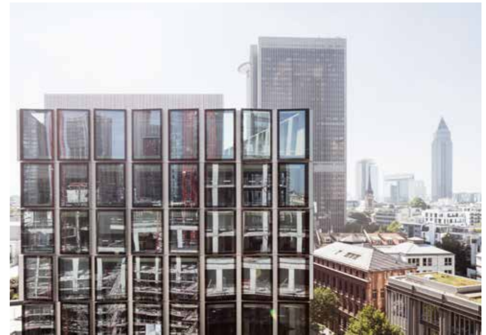
Fensterscheiben in unterschiedlichen Winkeln erzeugen ein lebendiges Fassadenbild Window-panes mounted at different angles bring the façade to life
