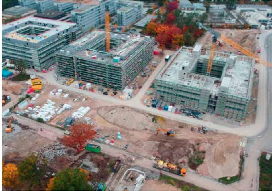
Baukastensystem mit vorgefertigten Bauelementen
