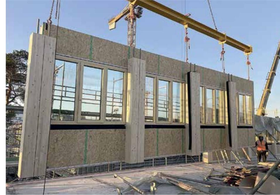
Vorgefertigtes Element in Holzhybridbauweise
