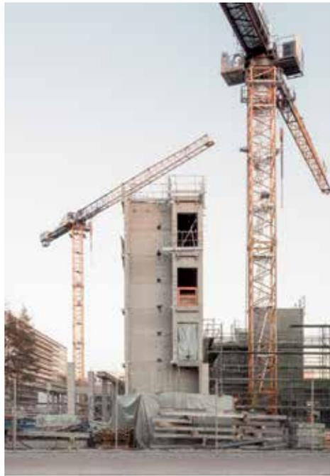
Systembauweise mit Betonfertigteilen
