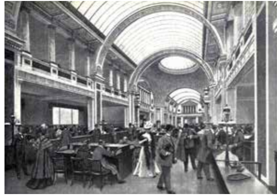
Haus 1 – Hauptkasse, 1910 House 1 - Main cash desk, 1910
