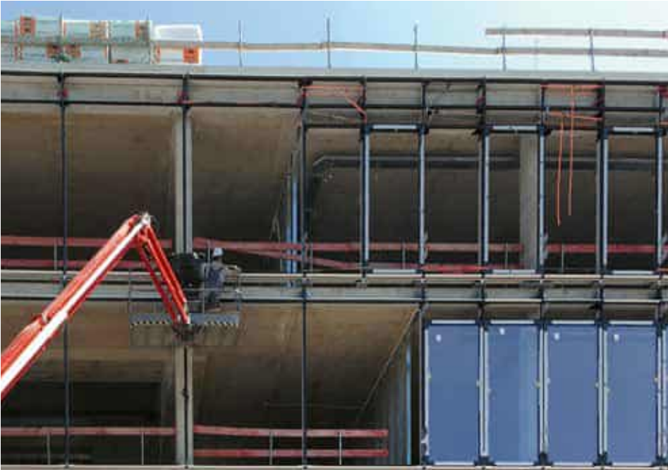
Montage der Fassadenelemente Installing the façade elements
