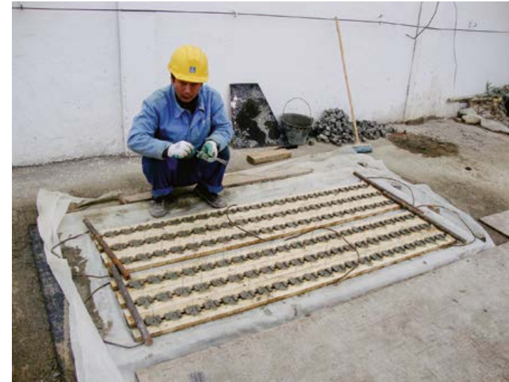
Herstellung von Abstandhaltern aus Gießbeton mit Ösendraht auf der Baustelle On-site production of cast concrete spacers with hanging wire
