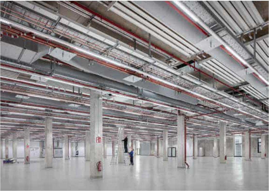
Produktionshalle Production hall
